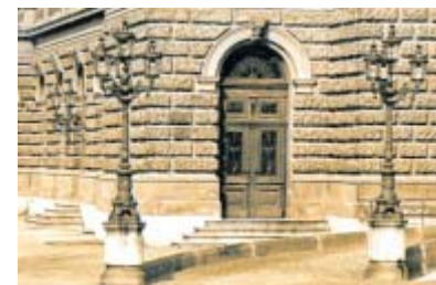
Am Stadtheater leuchteten mehrflammi- gaskandelaber besonders hell.
