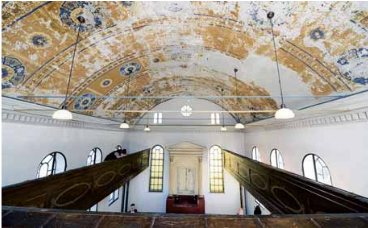
Hier beteten einst die jüdischen Mitbürger, die in Kriegshaber lebten. Heute ist die ehemalige Synagoge in der Ulmer Straße eine Außenstelle des Jüdischen Kultur Museums in der Innenstadt. Foto: Silvio Wyszengrad
